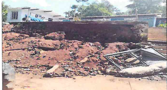
Foto 4: Reparación de muro perimetral
