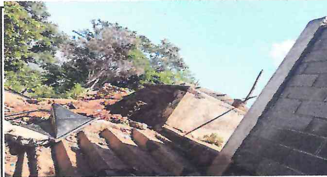
Foto 5: Reparación de muro perimetral
