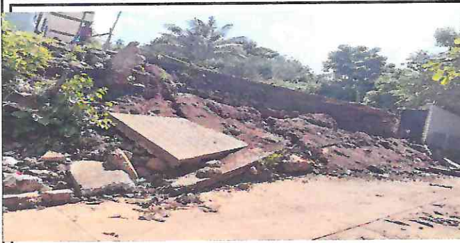
Foto 3: Reparación de muro perimetral
