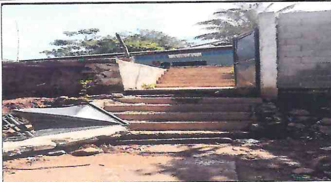
Foto 1: Reparación de gradas
