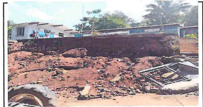
Foto 6: Reparación de muro perimetral
