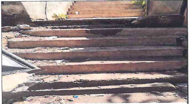
Foto 2: Reparación de porción
